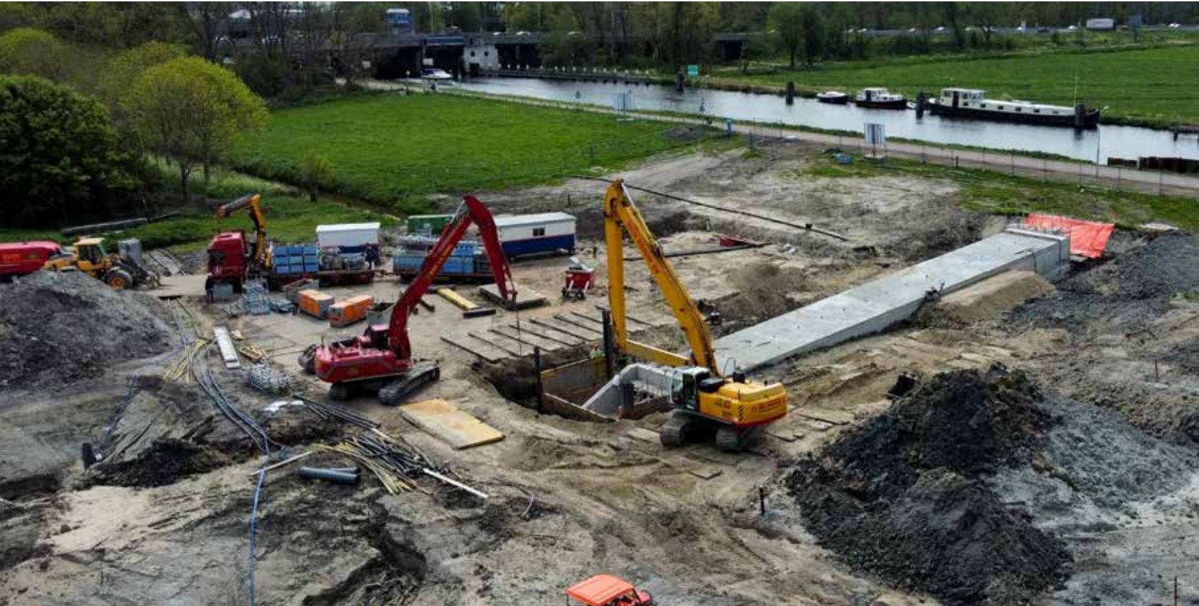
Om de druk van het materieel op de ondergrond te verlagen, heeft Roel van der Stoel gebruik gemaakt van schotten.
