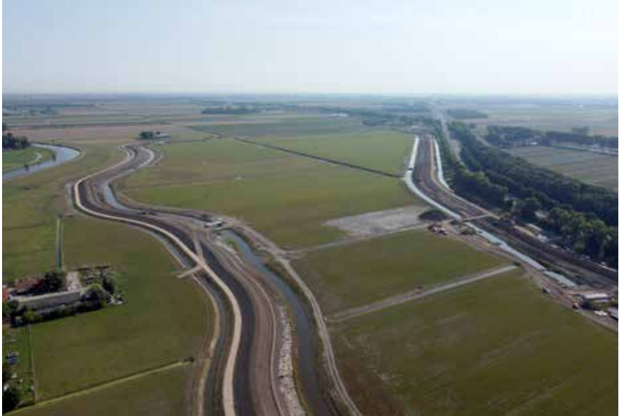
Het 3,8 kilometer lange dijklichaam is volledig vervaardigd met gebiedseigen grond.
