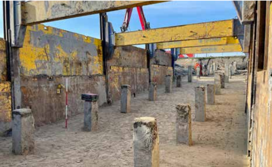
Roel van der Stoel was op dit project verantwoordelijk voor het ontgraven van zowel de uitlaatconstructie, het uitlaatkanaal en de woelkom.
